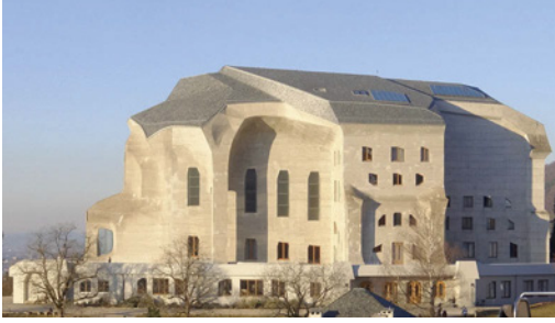
Abb. 4 – Der ausgeführte Bau
