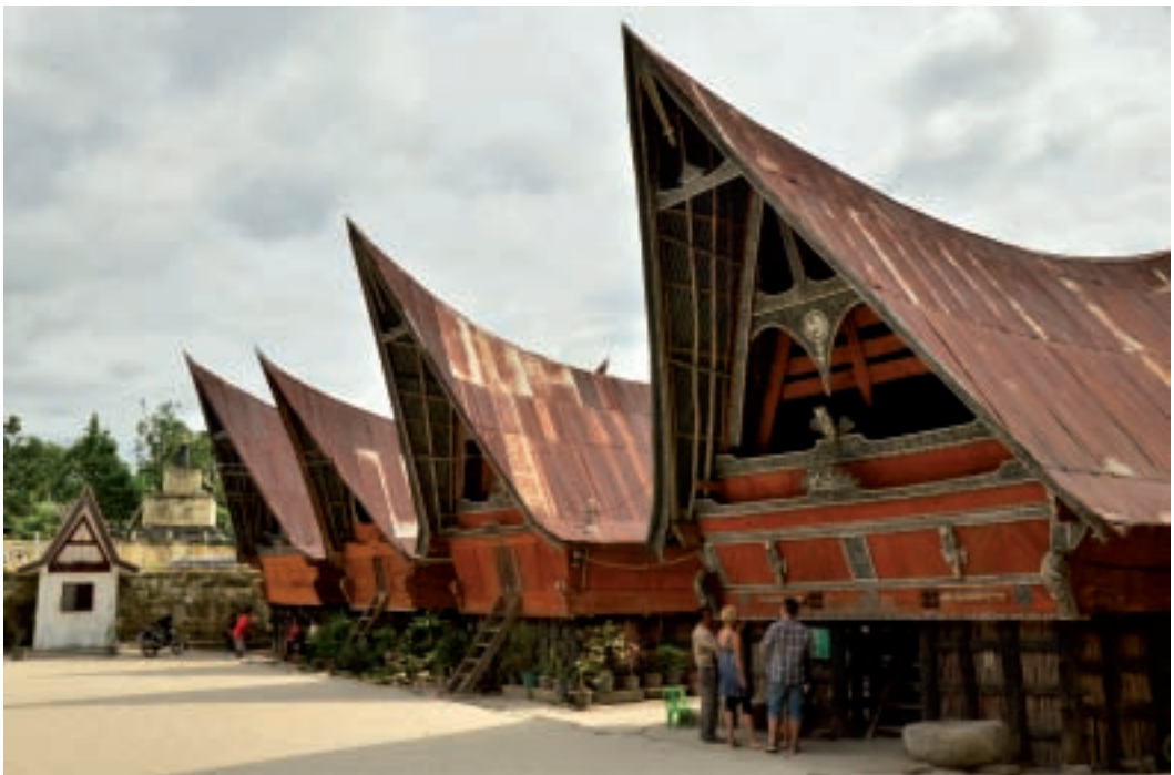
Da es keine Zuckerpalmen mehr auf Sumatra gibt, werden die Dächer mit Wellblech geflickt.
